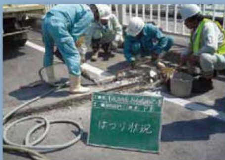
2 既設ジョイント撤去
