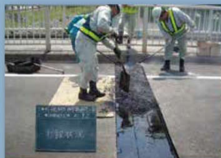
5 特殊合材打設
