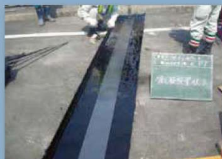
4 ギャッププレート設置
